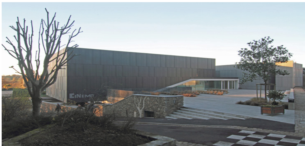
“Le Long Court” à Coutances – Architecte : Pierre Chican
