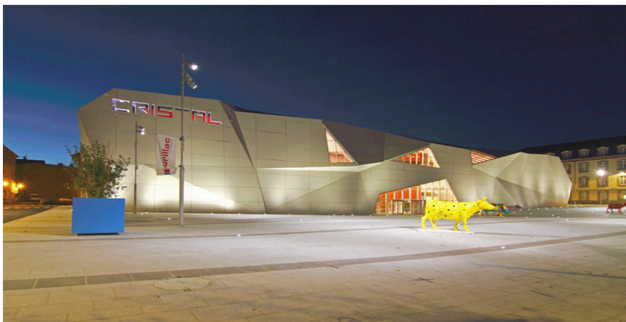
“Le Cristal” à Aurillac – Architectes : Linéaire A & Randja
